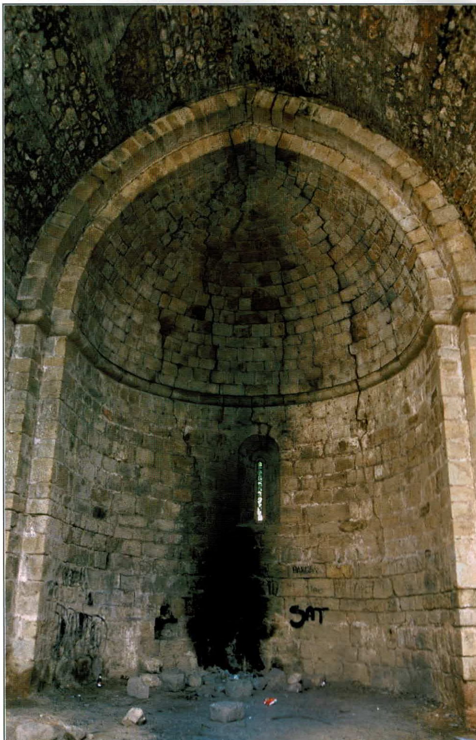
La volta encara es manté en bona part de la nau. A les fotos el presbiteri i l'absis: pintades, motocicletes i deixalles són mostres de la degradació del monument.
