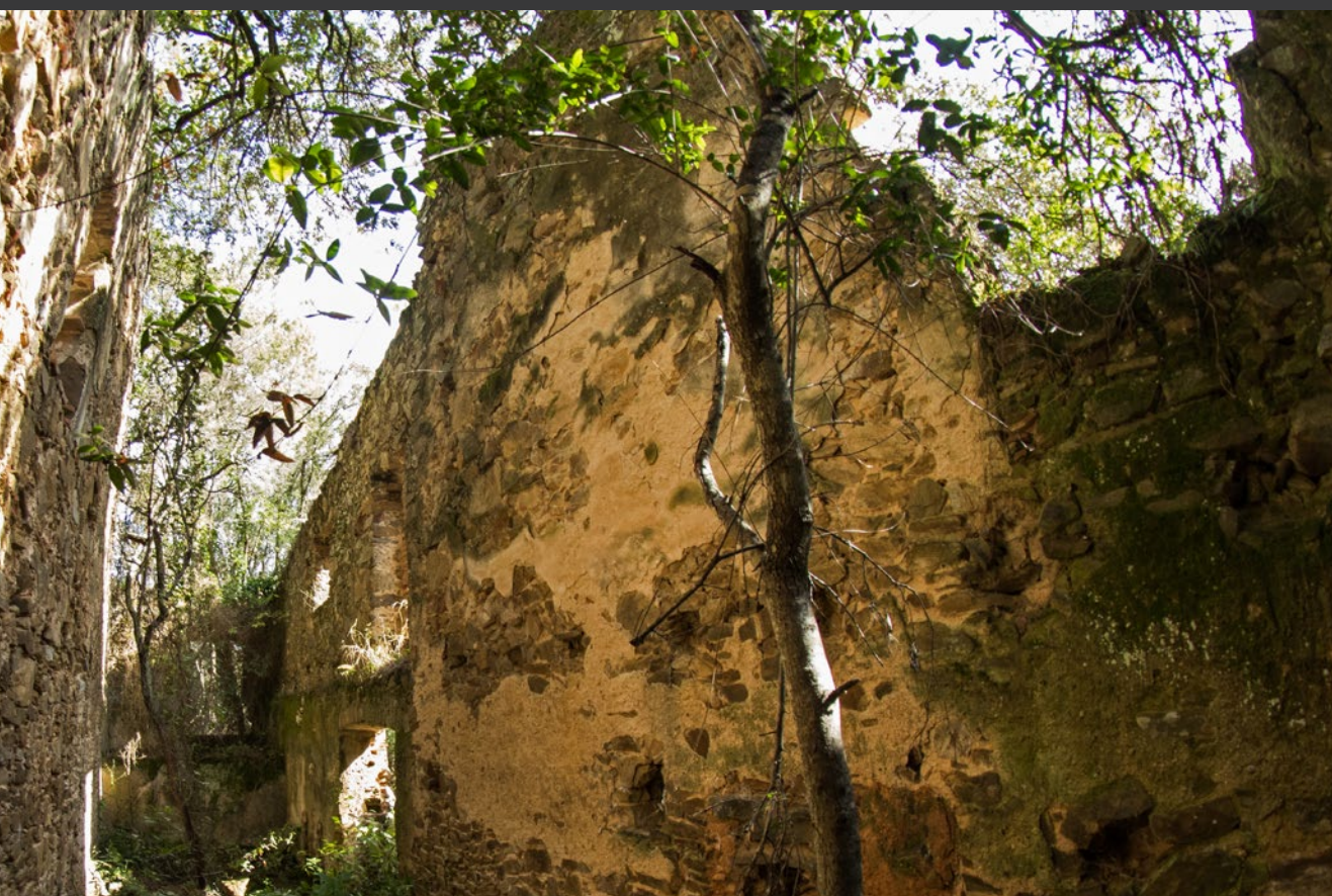
Can Parés, interior. Construïda amb pedra i morter de calç, encara aguanta els molts anys d'abandonament (fotografia de Bernat Rangil).
