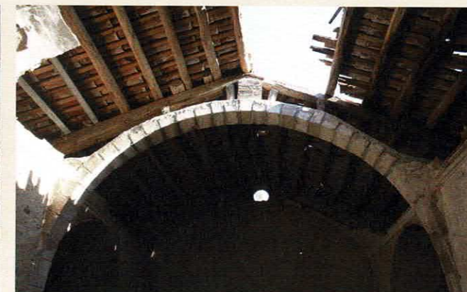
L'arc a punt de ser reparat amb el cindri col·locat. (Fotografia JM. Abril)
