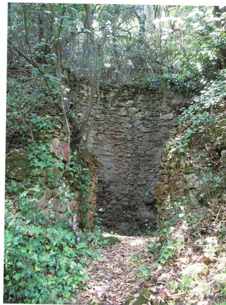
El forn de Can Caselles és el més gran dels conservats al Montnegre. La seva base té un diàmetre de gairebé 4'5 metres
