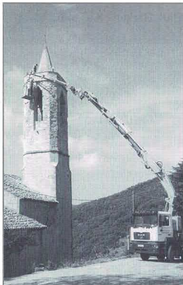
Un moment de les obres de reparació de l'església d'Hortsavinyà
