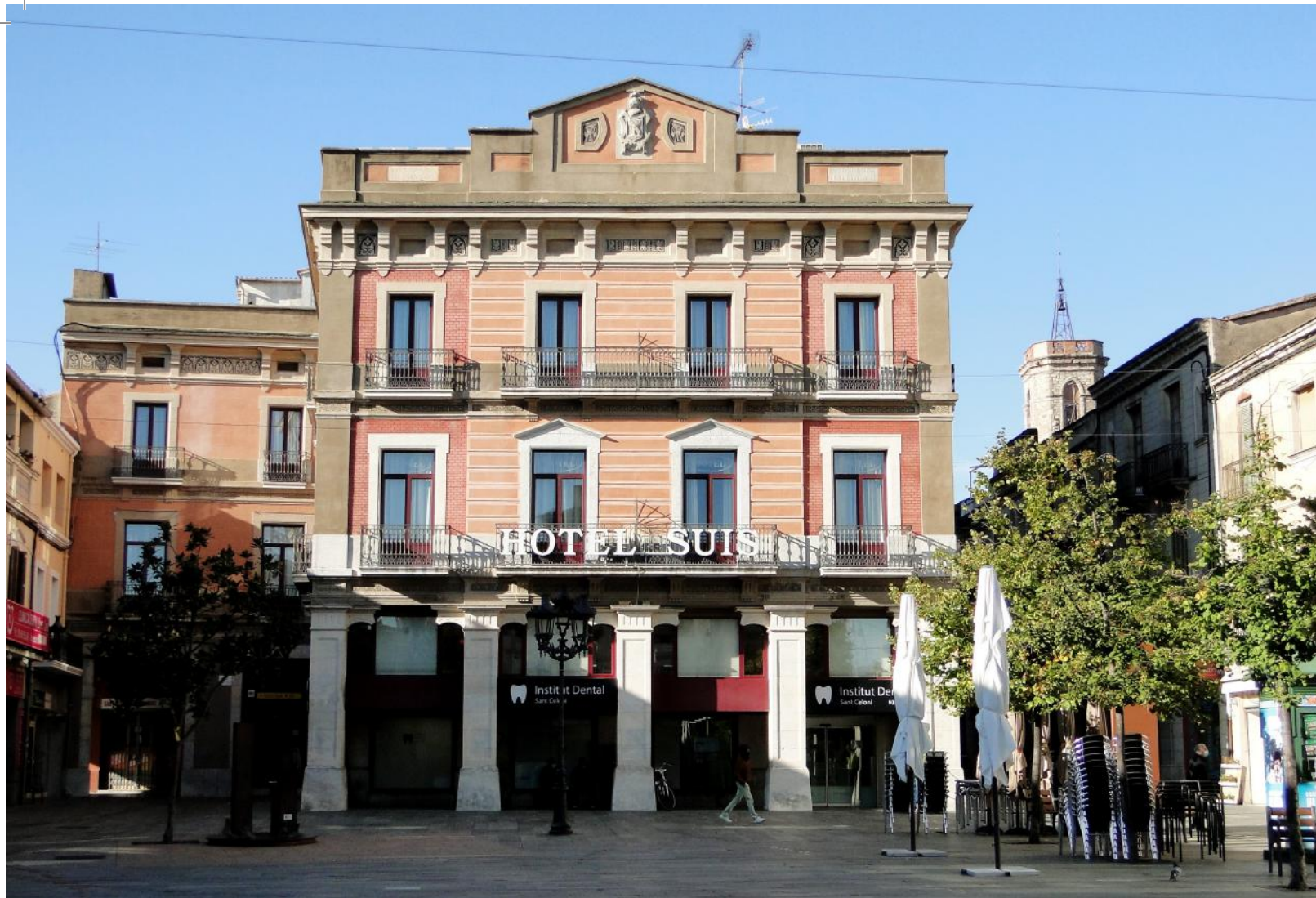
Hotel Suís, casal dels Valls d'Olzinelles a Sant Celoni, edificat el 1886 per Ramon de Valls. Va ser transformat en hotel l'any 1924 per Pius de Valls". Fotografia: Josep M. Abril, 2020.
