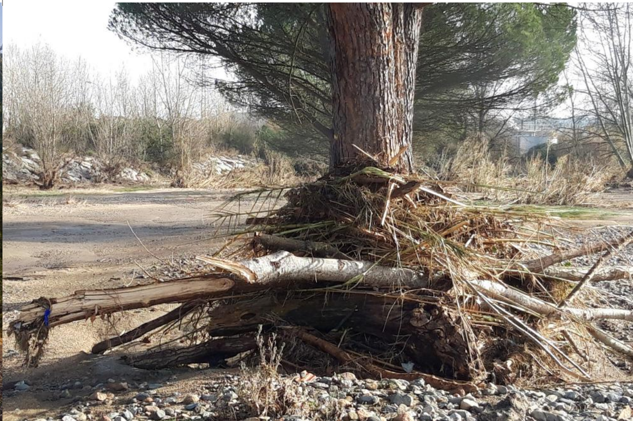
Detall del curs mitjà de la Tordera on es van fer retrocedir les expectatives urbanístiques de l'entorn del riu, i posteriorment s'han millorat les condicions hidràuliques ampliant la secció de la llera a base de retirar les motes en forma de cordó de terra. Foto: J. Pagès, 2020.
