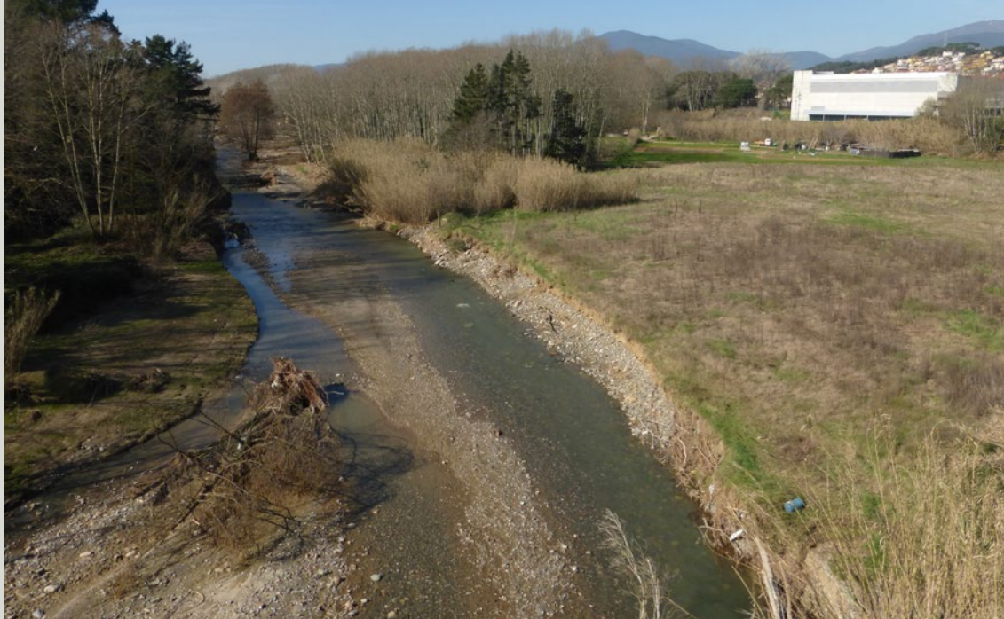
Figura 11: Erosió dels marges de la Tordera en el límit entre els municipis de Santa Maria de Palautordera i Sant Celoni. Imatge presa des del pont de la via fèrria un mes després de l'inici de la Torderada. Fotografia de Josep M. Panareda (10/2/2020).
