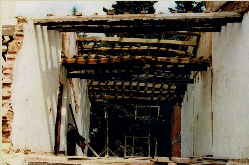
La carcassa de Can Mons: bigues de pi i parets de tàpia i totxo
